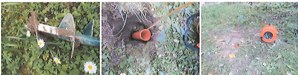
Foto 2, 3, 4 - Trivella elicoidale, tubo di rivestimento in pvc e lettura piezometrica.
